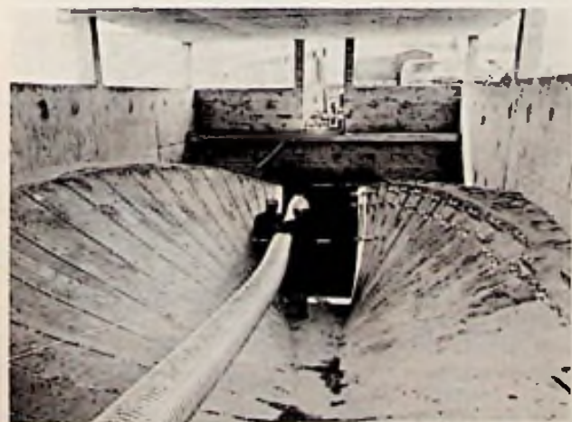
Afb. 1. Kabel komt uit het antenne-kiescentrum. Langs beide zijwanden komen vijf kabels.
